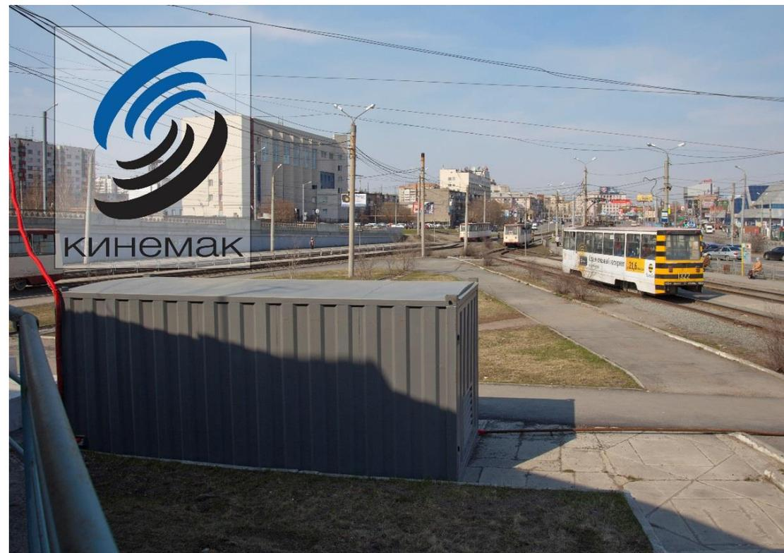
Определение оптимальных мест установки стационарных буферных накопителей НКЭ-3Г производится на основе анализа показателей, полученных с помощью ПМКС-01. Накопители позволяют снизить энергопотребление на тягу на данном участке до 30-35%.
